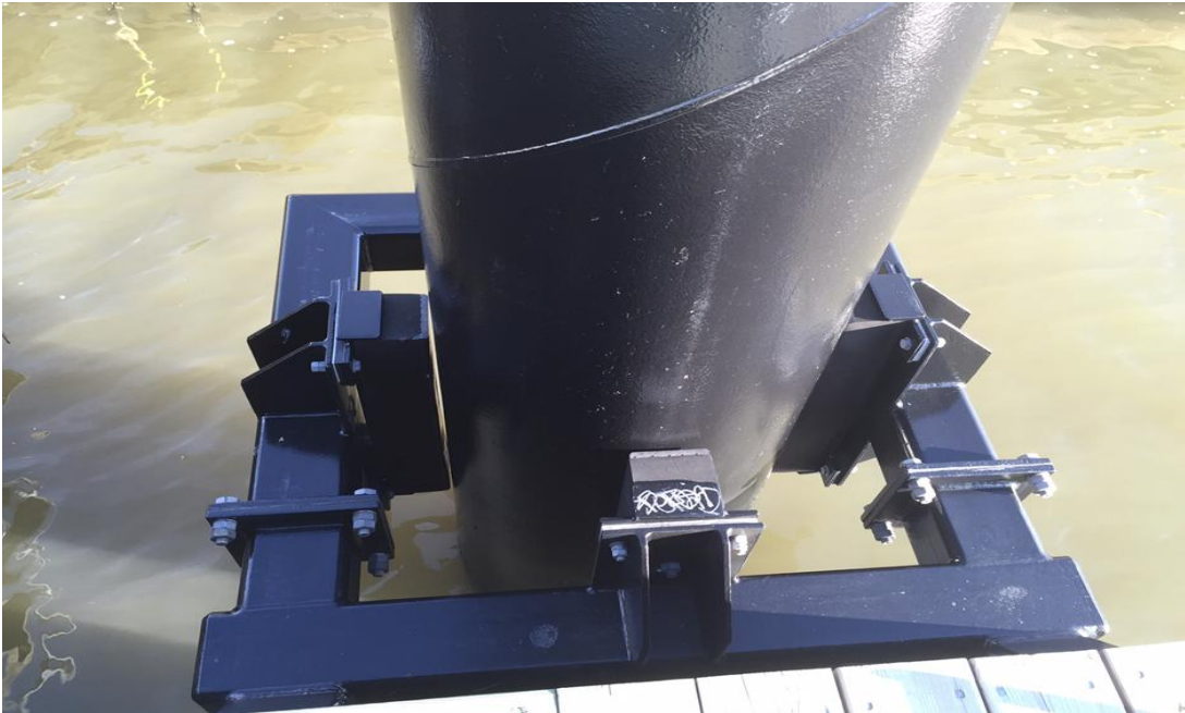
Bild 4: Slottsbergets flytbrygga med påle, pålkragar och fendorar
