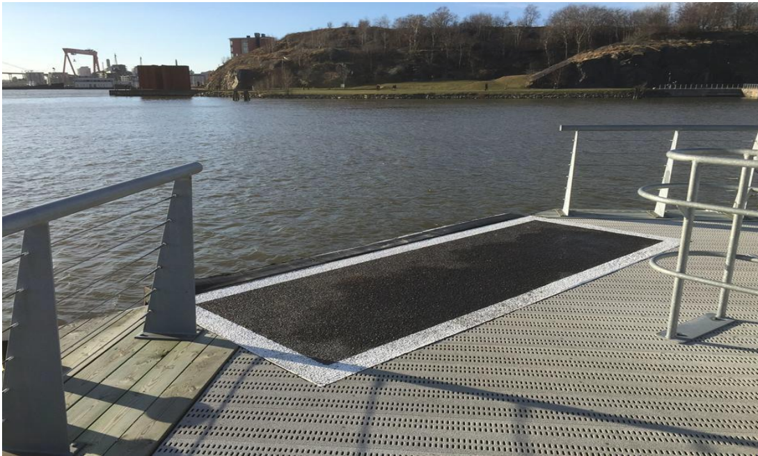
Bild 2: Slottsbergets flytbrygga med Acrudur belagd angörningsplats som kontrastmålat.
