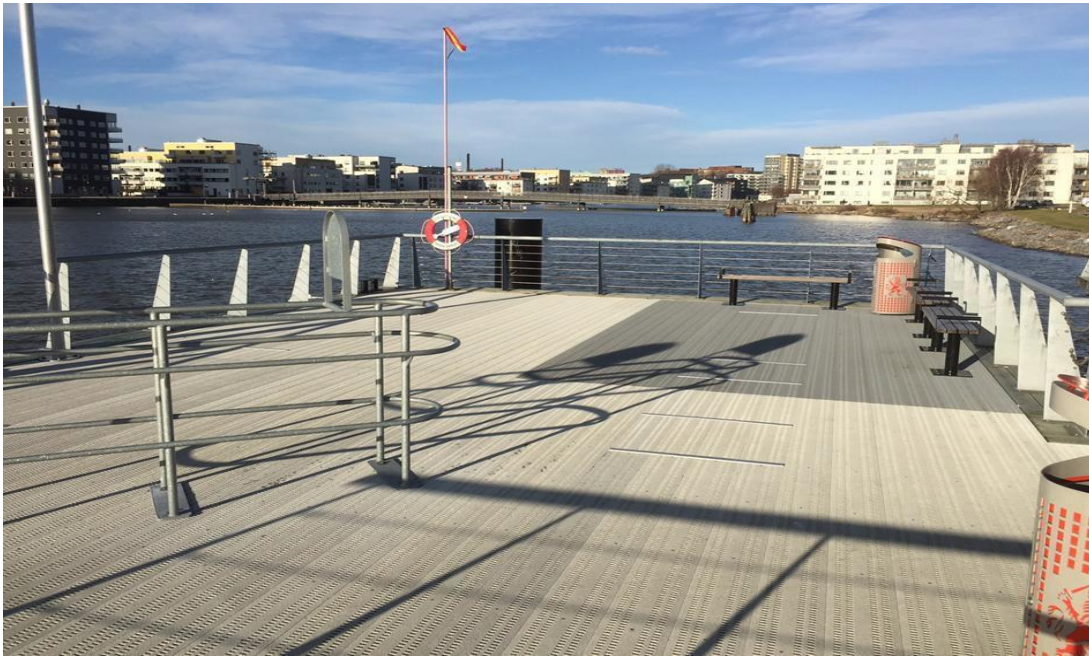
Bild 1: Slottsbergets Flytbrygga med halkskyddad Sapaprofil
