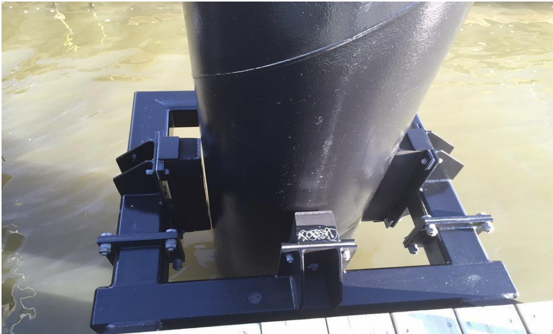
Bild 4: Slottsbergets flytbrygga med p le, p lkragar och f ndrar
