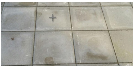
Figur 3. Placering av givare under stensättning. Editerad bild: Magnus Sjöalt
