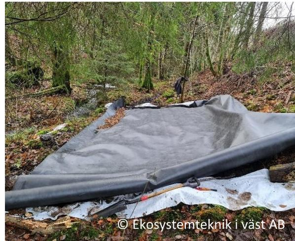
Figur6. Cirka 40cm djupt dike hand grävs runtomkring övertäckningsområdet. Marken jämnas ut och kontrolleras för vassa föremål som kan skada duken.
