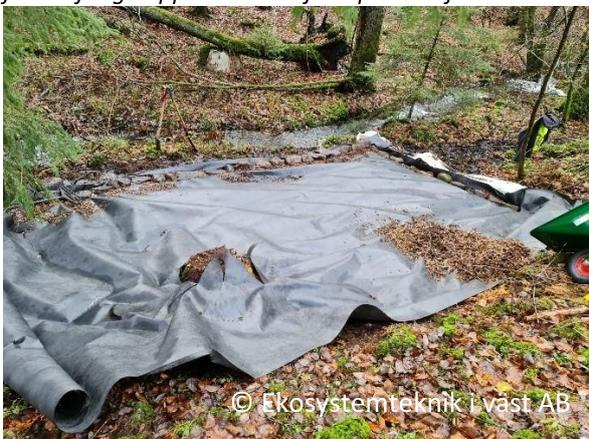
Figur 7. Ogräsduken läggs ut och förankras genom att diket, runt duken, fylls med stenar från området. Påbörjad täckning med löv och stockar för att hålla duken på plats och skydda den från UV- strålning.
