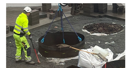
Stålcylinder lyfts upp.
