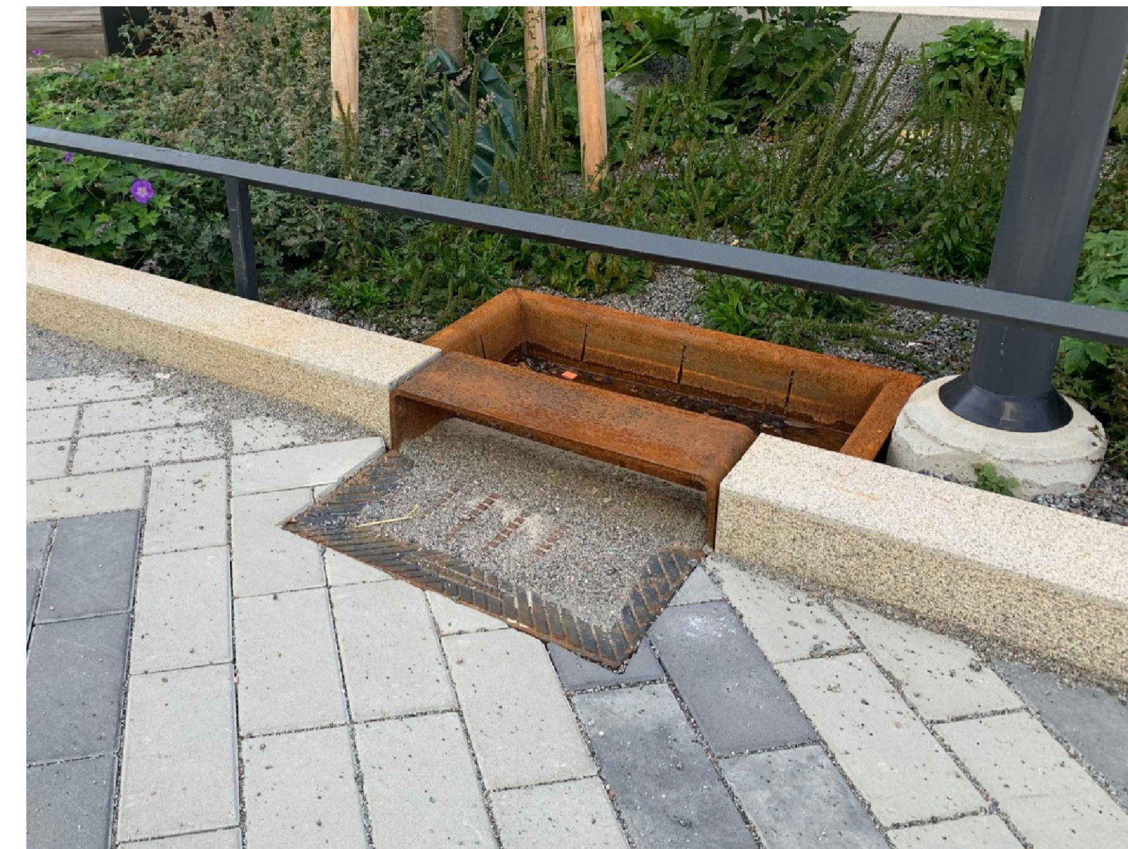
BILD INLOPP: EX. PÅ INLOPPSPLATTA, BYGEL OCH SANDFÅNGSKAR
