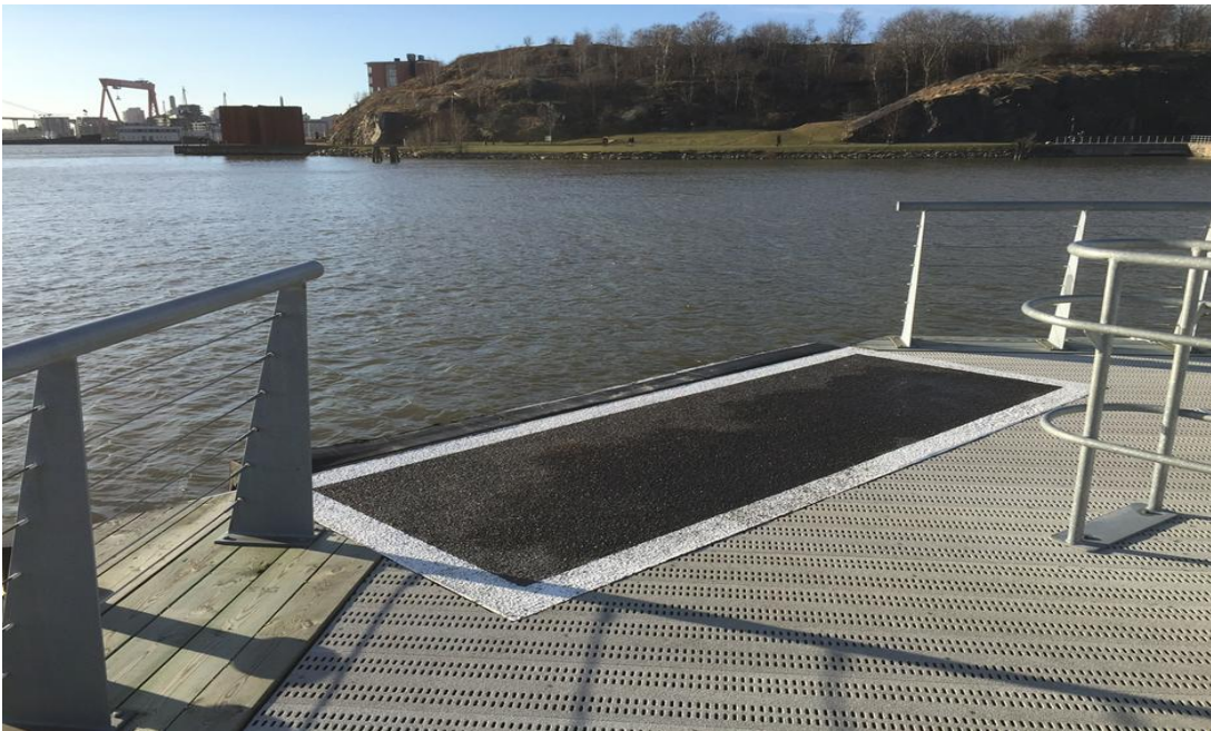
Bild 2: Slottsbergets flytbrygga med Acrudur belagd angörningsplats som kontrastmålats.
