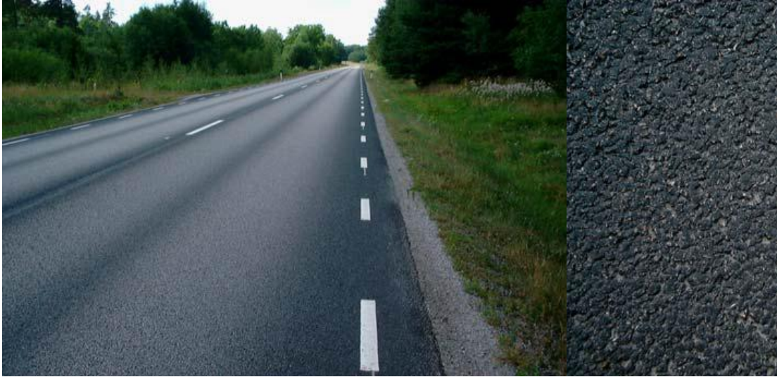
Figur 33: ABS – stenrik asfaltbetong med relativt mörkt stenmaterial. Stenarnas ljushet är viktig för ljusreflexionen eftersom de förekommer rikligt på ytan. Bild: VGU 2004.
