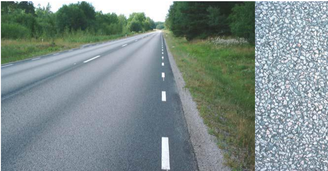
Figur 32: ABS – stenrik asfaltbetong med relativt ljust stenmaterial. Stenarnas ljushet är viktig för ljusreflexionen eftersom de förekommer rikligt på ytan. Bild: VGU 2004.
