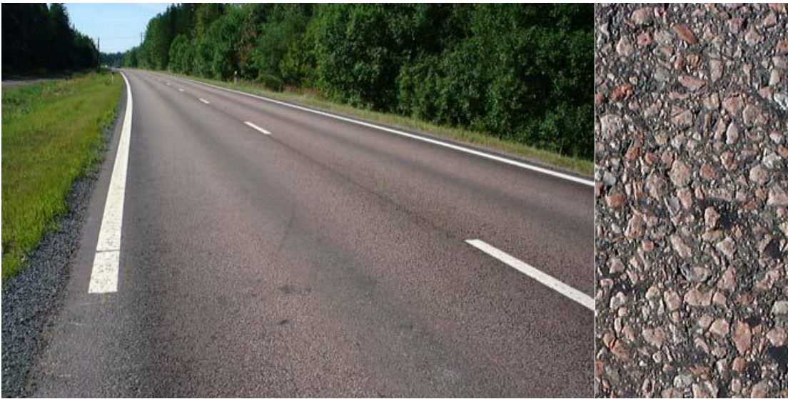
Figur 34: TSK – tunnskiktbeläggning. Stenarnas ljushet är viktig för ljusreflexionen eftersom de förekommer rikligt på ytan. Materialet på bilden är porfyr. Bild: VGU 2004.
