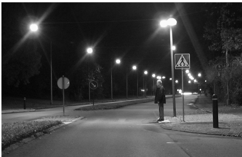
Figur 20: En insnävning gör att bakgrunden till stor del utgörs av den belysta väg ytan bakom övergångsstället, vilket gör att åtminstone halva fotgängaren framträder i negativ kontrast. Övergångsstället på bilden är dessutom försett med extra belysning som framhäver fotgängarens huvud och överkropp mot den mörka vegetationen i bakgrunden. Bild: Sara Nygårdhs, VTI.
