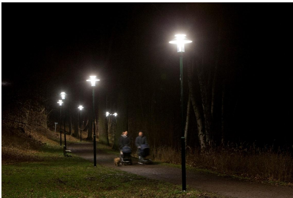
Figur 8: Förekomst av träd är av betydelse vid valet av stolphöjd och stolplacering. Bild: Lennart Johansson.
