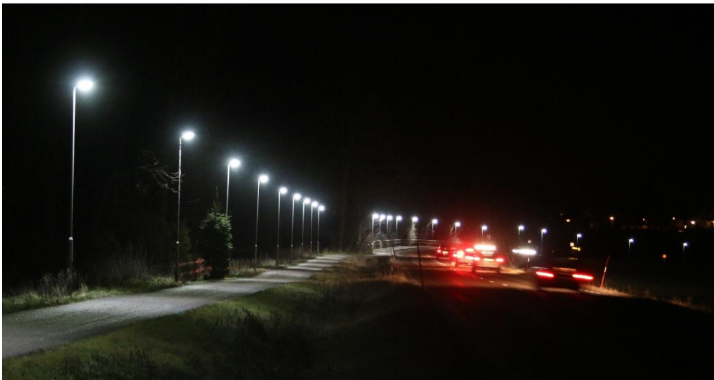
Figur 30: Belyst GC-väg intill obelyst körbana. Bild: Joel Rosdahl.
