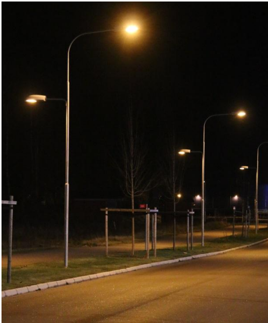
Figur 29: Stolpar med olika höjd för armaturerna över GC-väg respektive körbana. Bild: Joel Rosdahl.
