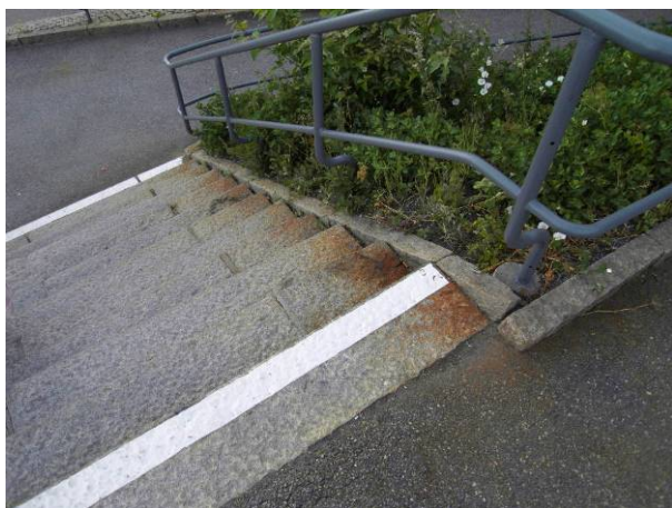
Granittrappa kontrastmarkerad på första och sista trappsteget.
