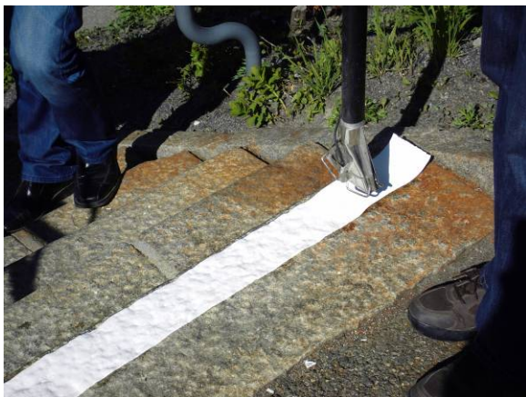
Kontrastremsan värms fast med brännare.
