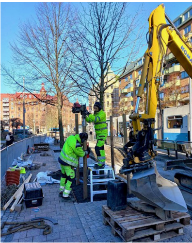
Var noggrann att störar inte slås ned i rotklumpen.
