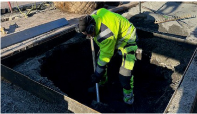
Förberedande nivåjustering i trädgrop inför trädplantering.
