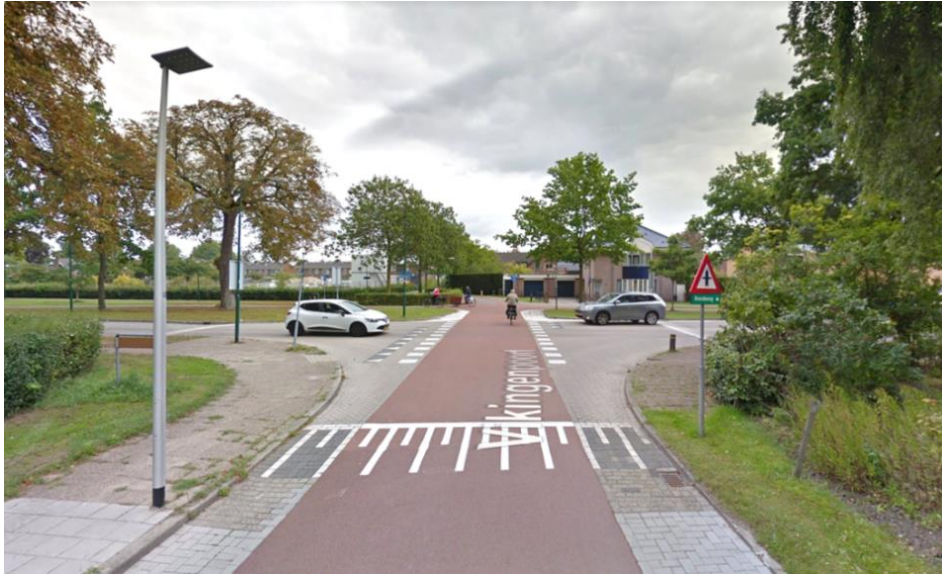
Figur 14. Cykelanpassad gata inom villaområde med väjningsplikt för trafiken från sidogator. Markeringen tvärs över den cykelanpassade gatan är standard samt att markera fartgupp och upphöjda korsningar i Nederländerna.
