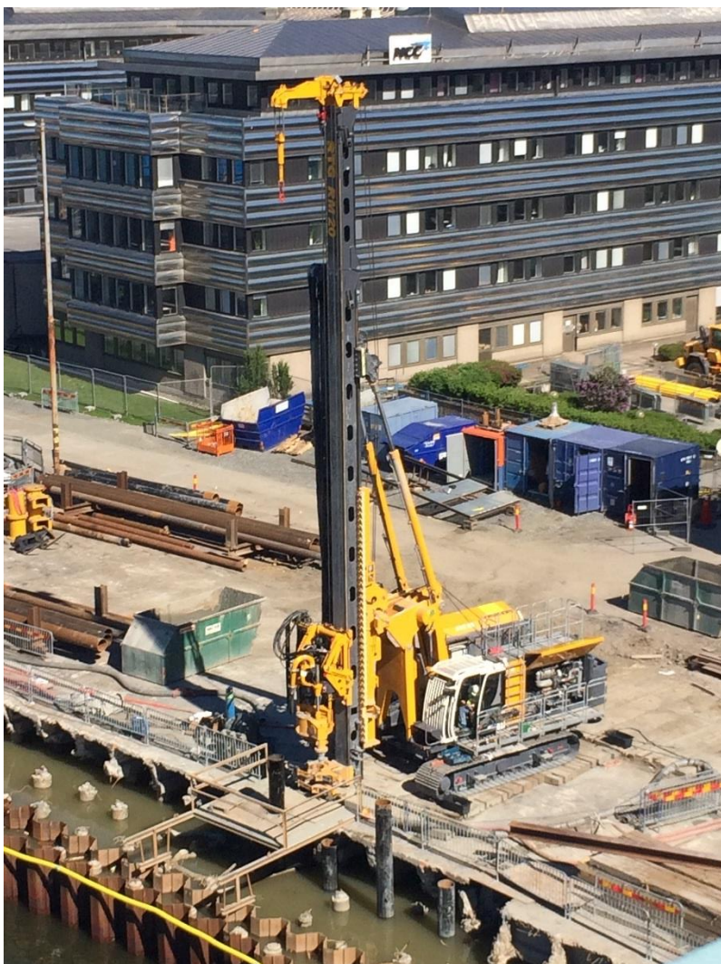
Figur 19: Spontning, foto: Philip Radtke, Sweco, 2017
