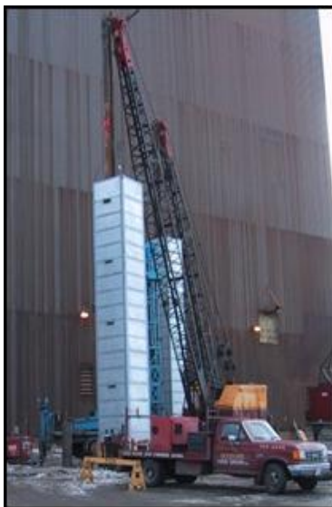
Figur 4: Avskärmning för pålning, exempel 1 (U.S. Department of Transportation - Research and Innovative Technology Administration, 2006)
