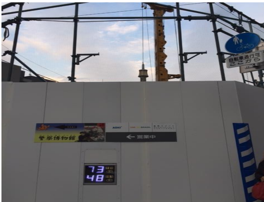
Figur 1: Ljudnivåmätare på fysisk begränsning av byggarbetsplats (Dunne, 2017)
