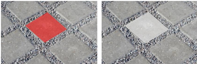
Figur 1 och 2. Placering av givare under mark. Editerade bilder: Magnus Sjöalt
