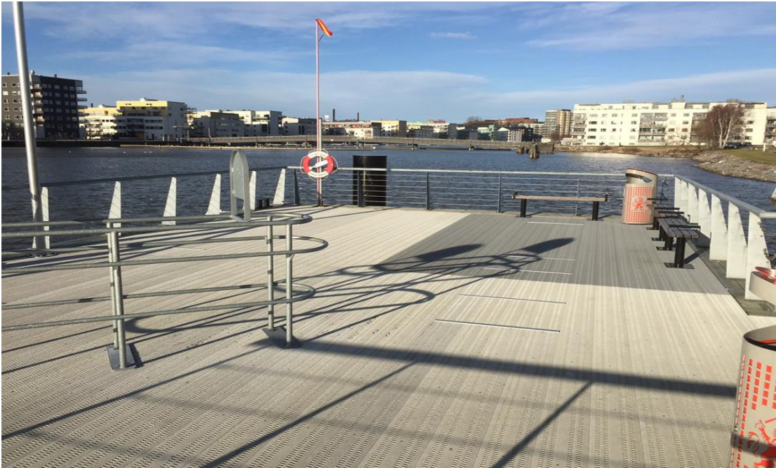
Bild 1: Slottsbergets Flytbrygga med halkskyddad Sapaprofil
