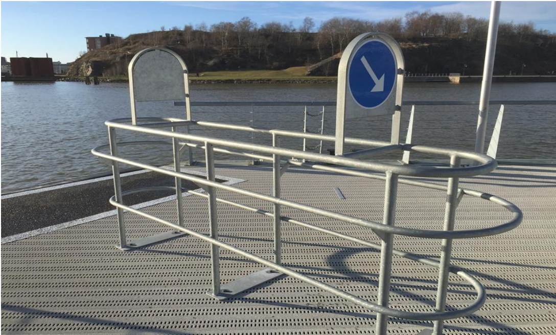
Bild 3: Slottsbergets flytbrygga trafikdelare med handledare och skyltning.
