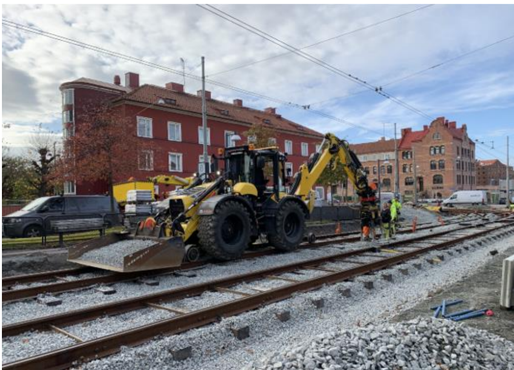
Figur 1 Packning, traktor som vibrerar sliper i grus.
