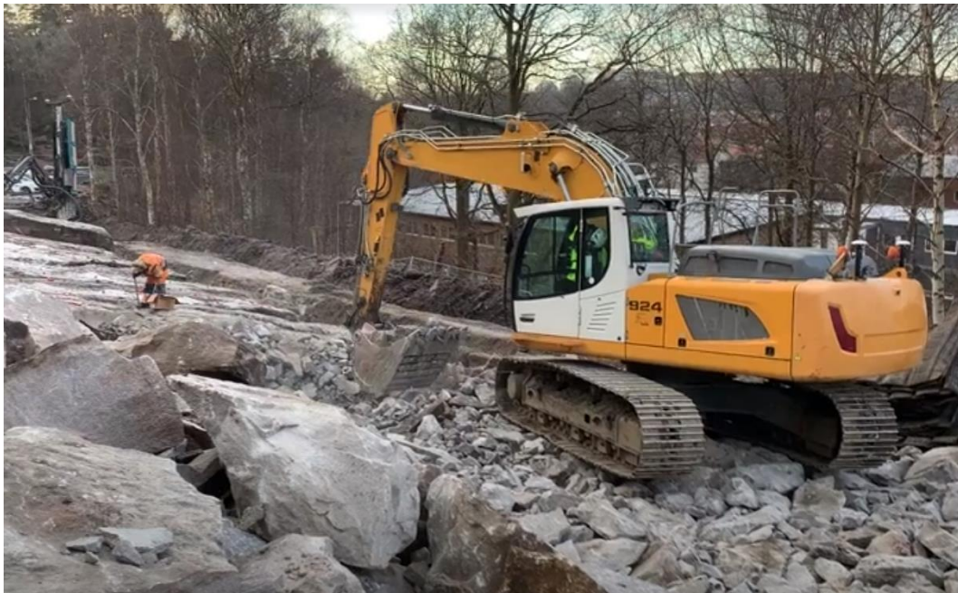
Figur 9 Grävmaskin flyttar sprängsten
