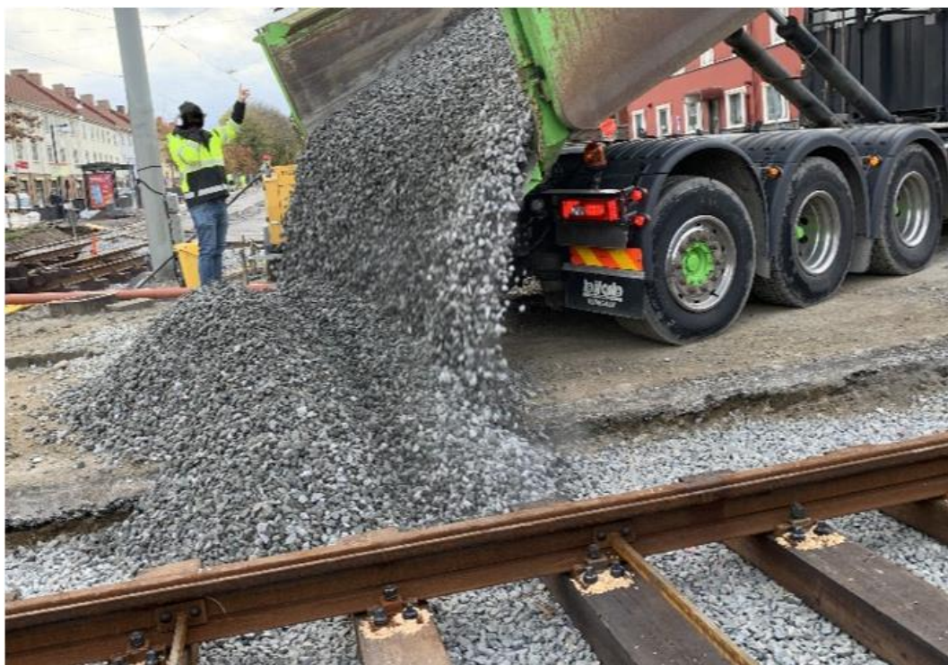
Figur 7 Tömning av grus från dumper
