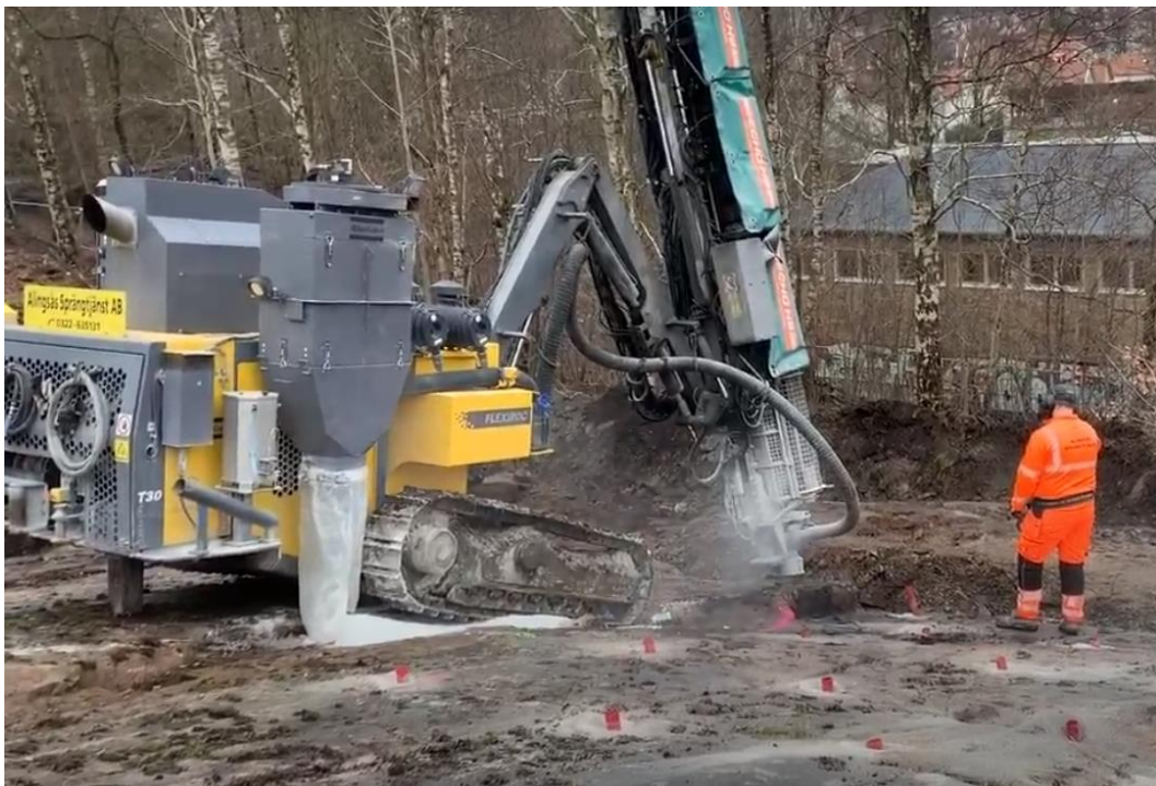
Figur 10 Bormaskin, förbereder språnghål i berg
