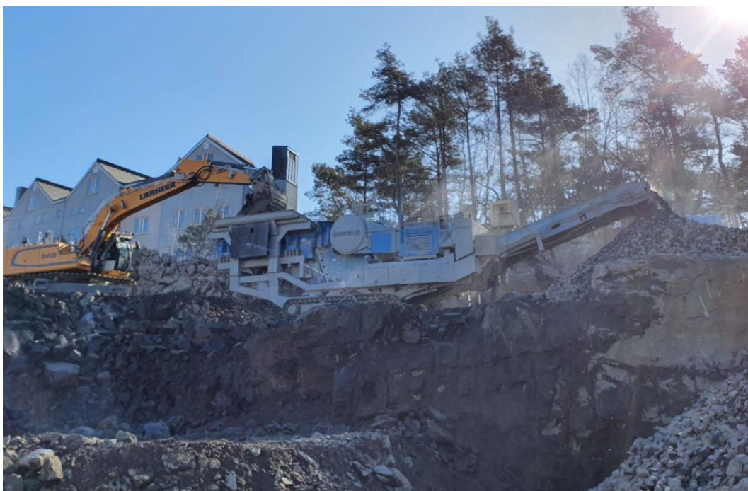
Figur 12 Grävmaskin lastar sprängsten
