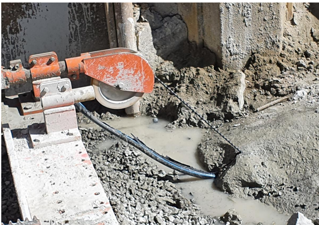
Figur 13 Sågning i berg med vadersåg
