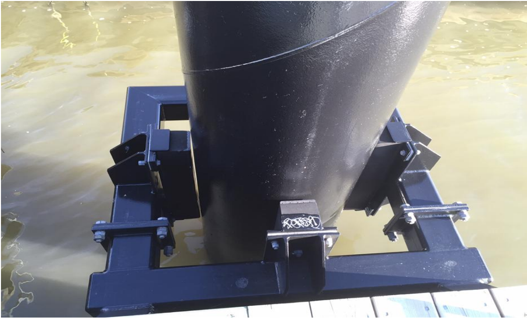
Bild 4: Slottsbergets flytbrygga med påle, pålkragar och fendorar
