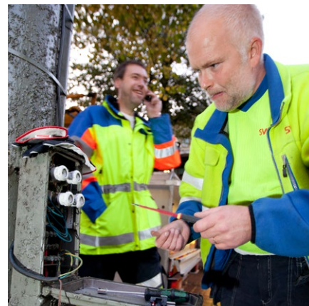
Reparation av belysningsstolpe.
