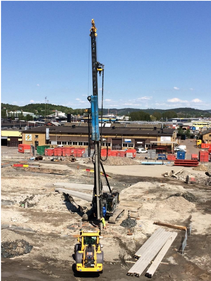
Figur 18: Pålning, foto: Philip Radtke, Sweco, 2017
