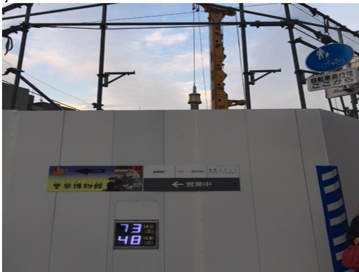
Figur 1: Ljudnivåmätare på fysisk begränsning av byggarbetsplats (Dunne, 2017)
