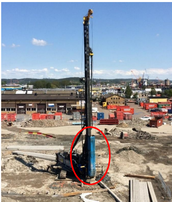
Figur 7: Absorberande material på en begränsad del av pålen (inringat i rött)
