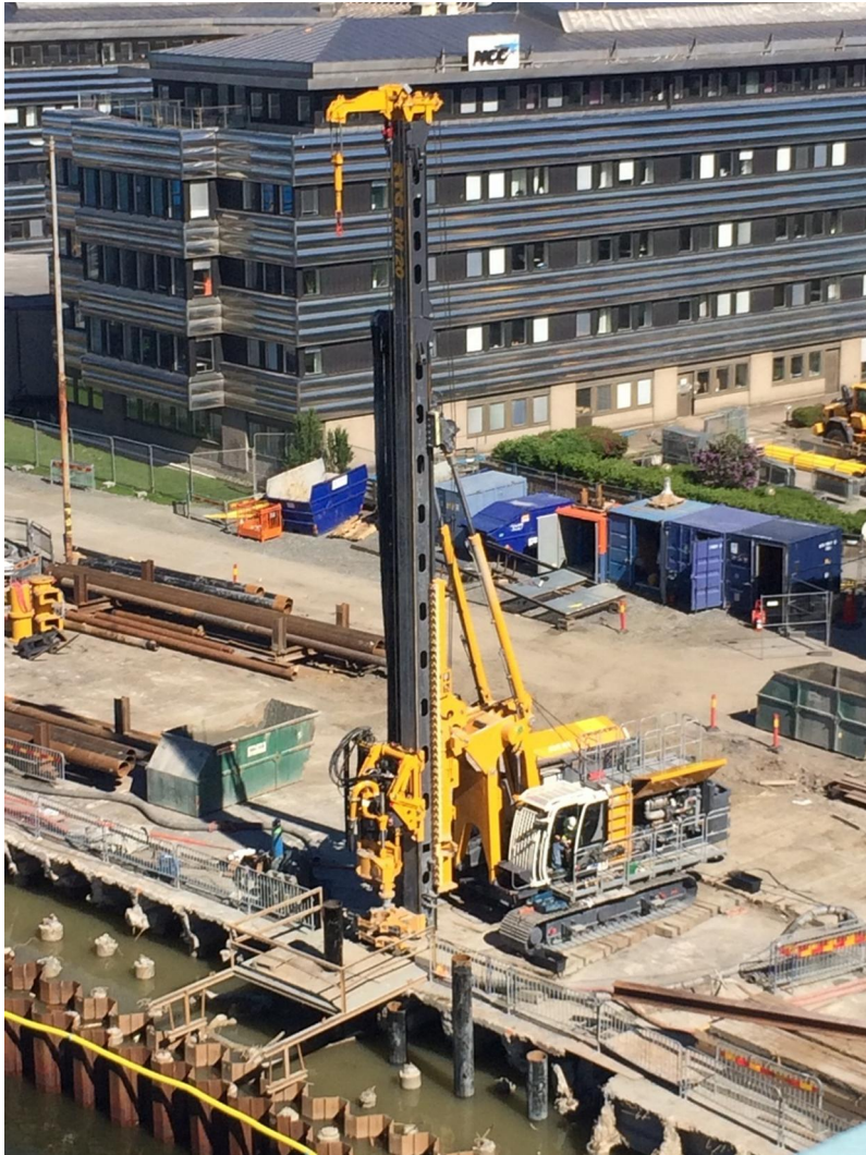
Figur 19: Spontning, foto: Philip Radtke, Sweco, 2017
