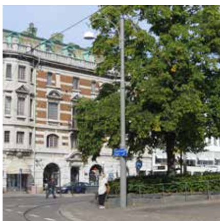
Ljust gultonad mellangrå används på infrastrukturutrustning såsom kontaktlednings- och belysningsmaster.
