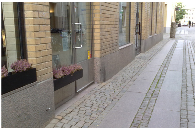
Magasinsgatan. En mindre höjdskillnad har tagits upp i gångbanan.
