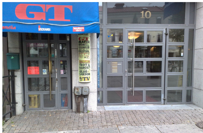
Avenyn. En mindre höjdskillnad har tagits upp i gångbanan.
