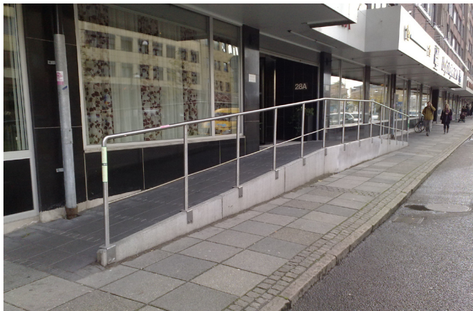
Första Långgatan. Gångbanans fria bredd understiger två meter.
