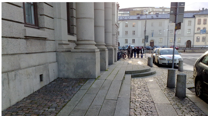
Packhusplatsen. En höjdskillnad på ca 30 cm har tagits upp på ett sätt som stämmer väl överens med byggnadens och platsens karaktär. Observera att rampen saknar avvägningsskydd och räcke.
