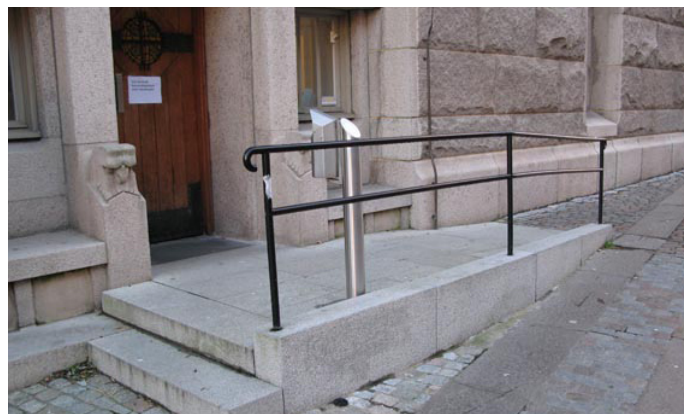
Kungsgatan 11. En höjdskillnad på ca 30 cm har tagits upp i en ramp med trappa från sidan.
