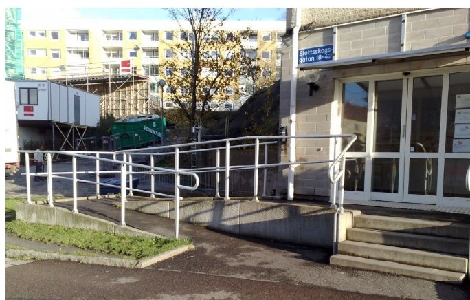
Slottsskogsgatan. En höjdskillnad på över 50 cm kräver vilplan. Rampens serpentinform ger en "skog" av räcken.
