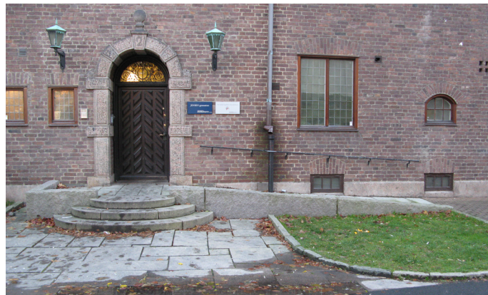
Lyckans Väg. Befintliga trappsteg har flyttats ut och ramp och trappa har blivit en väl integrerad helhet.
