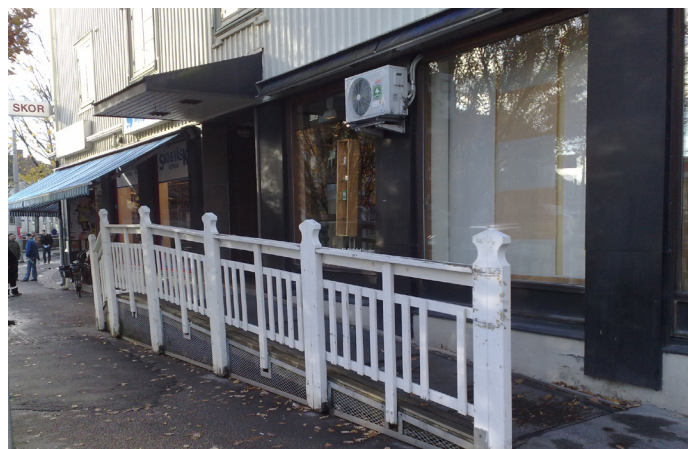
Mariaplan, ramp i trä. Trämateriell är underhållskrävande och kan uppfattas som främmande i stadsbilden.
