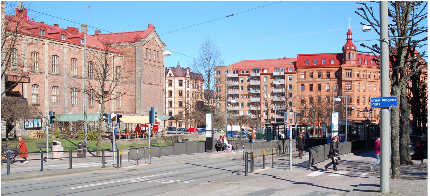
Bild 20. Prinsgatans spårövergång från söder
